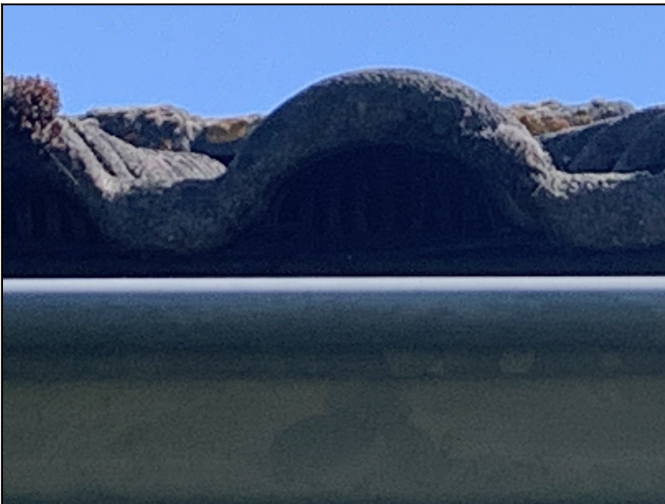
Afbeelding 10. Vogelschroot onder de dakpannen van gebouw 1 en 2 (Foto: L. Boon | Ecoresult B.V.).
