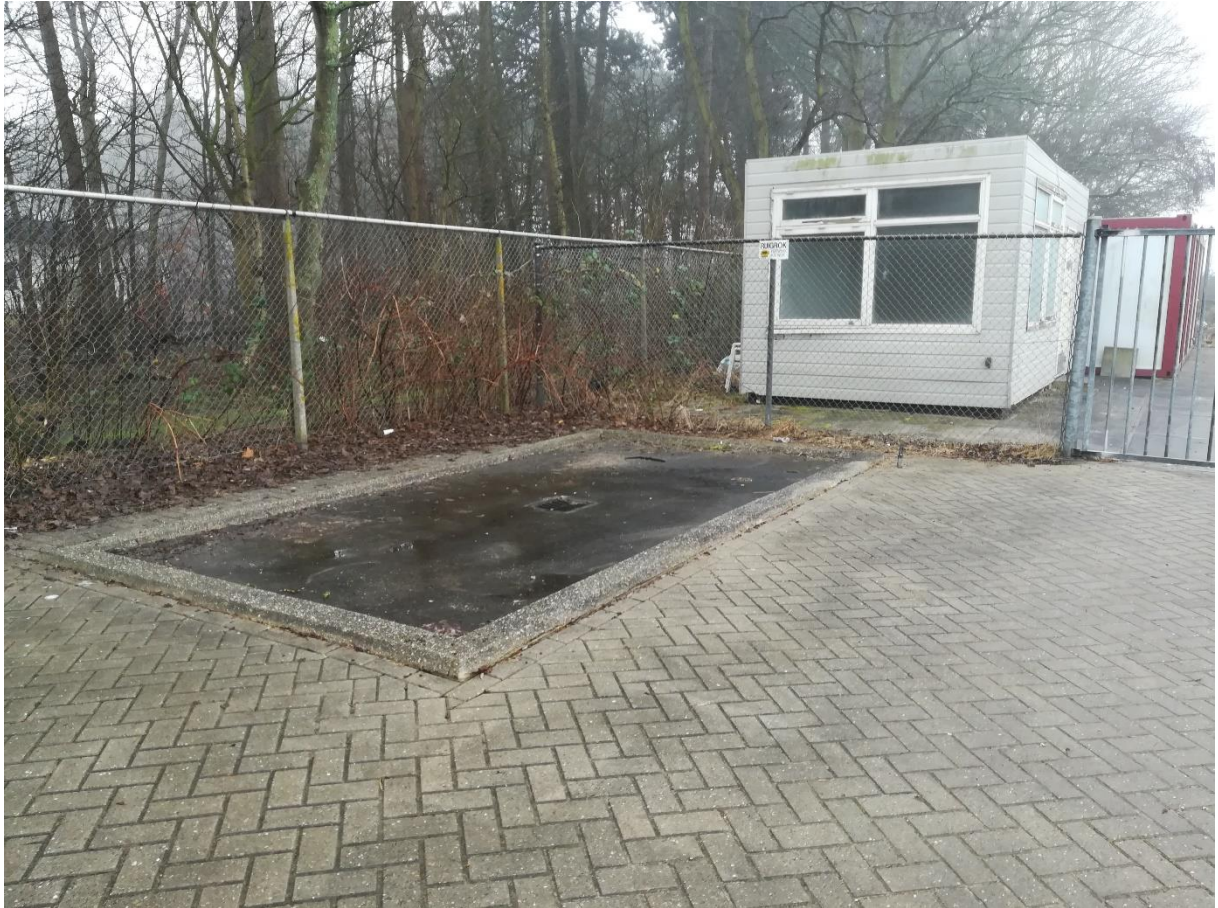
44. Betonnen wasplaats direct naast gebouw N
