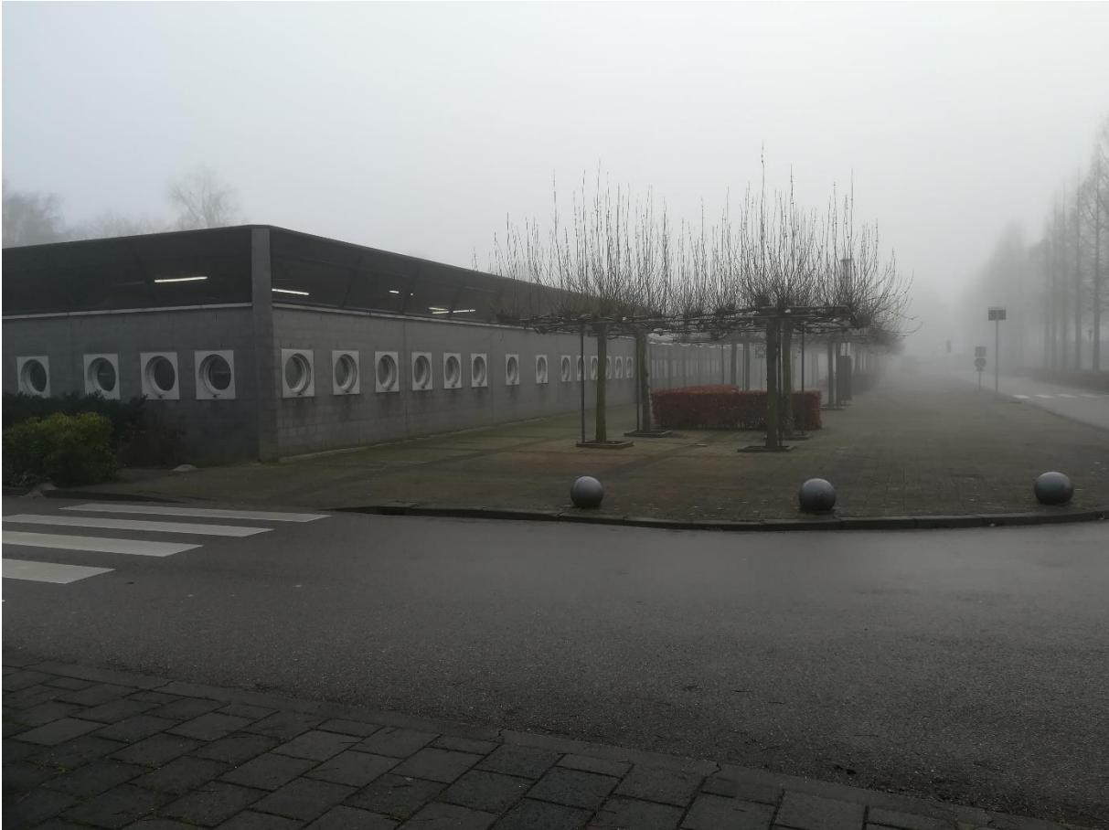
5. Gebouw P (Werk en Activiteitencentrum)
