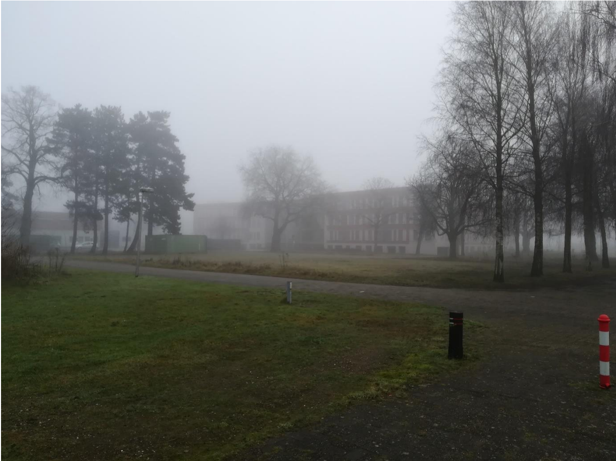
38. Gebouw R (Kliniek)
