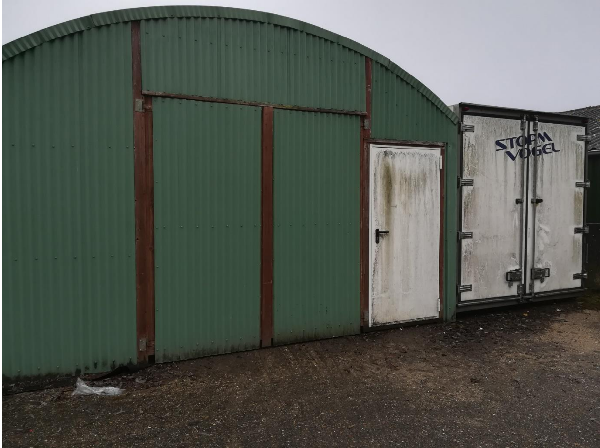
47. Opslag van afval en chemicaliën (kleinschalig) in Milieupark
