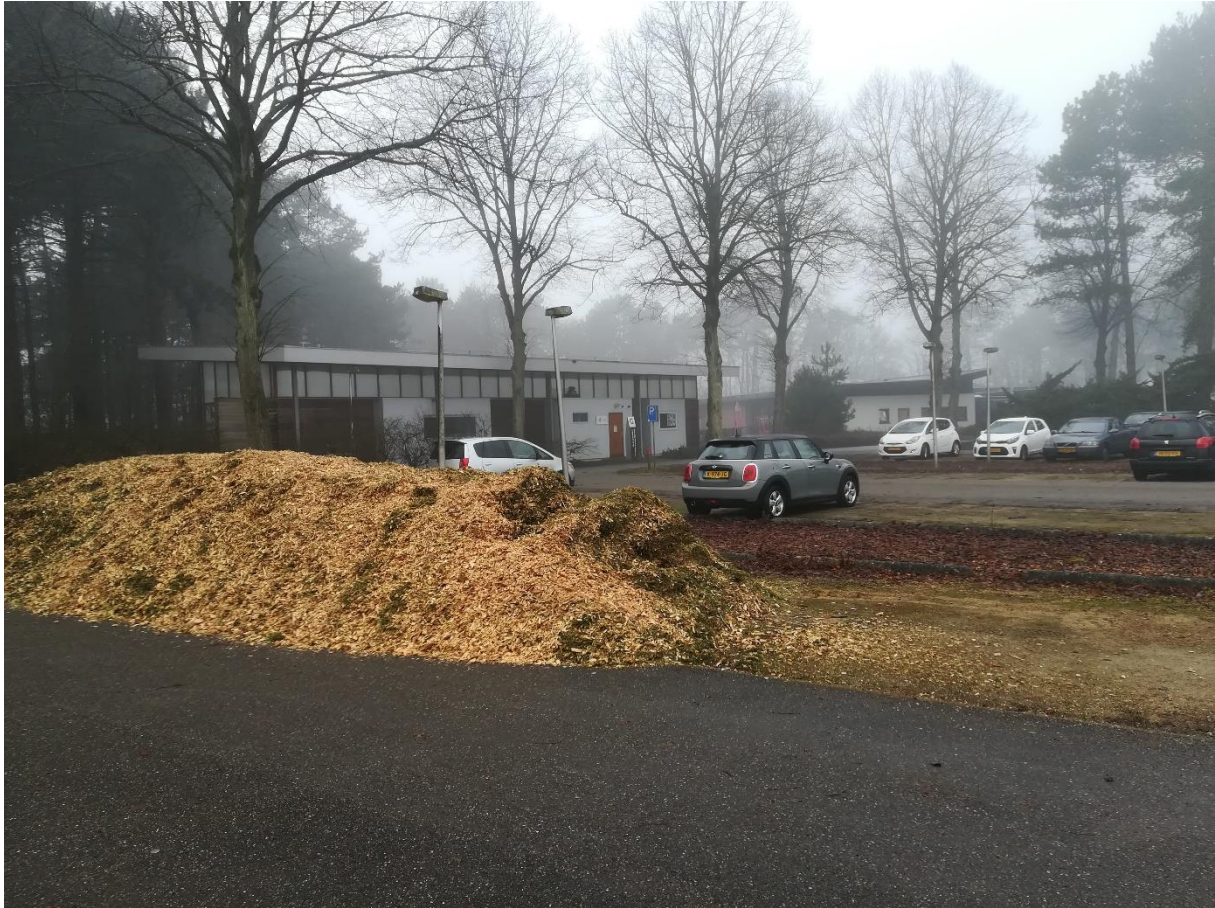
22. Gebouw G (BSO Jip & Janneke), naast parkeerplaats met halfverharding en depot met houtsnippers
