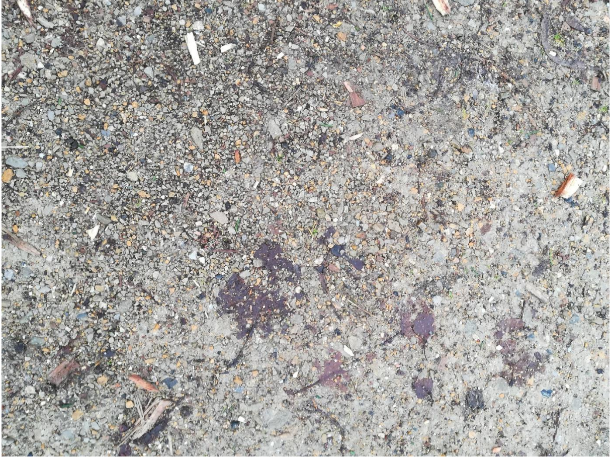
25. Close-up halfverharding parkeerplaats bij gebouw G
