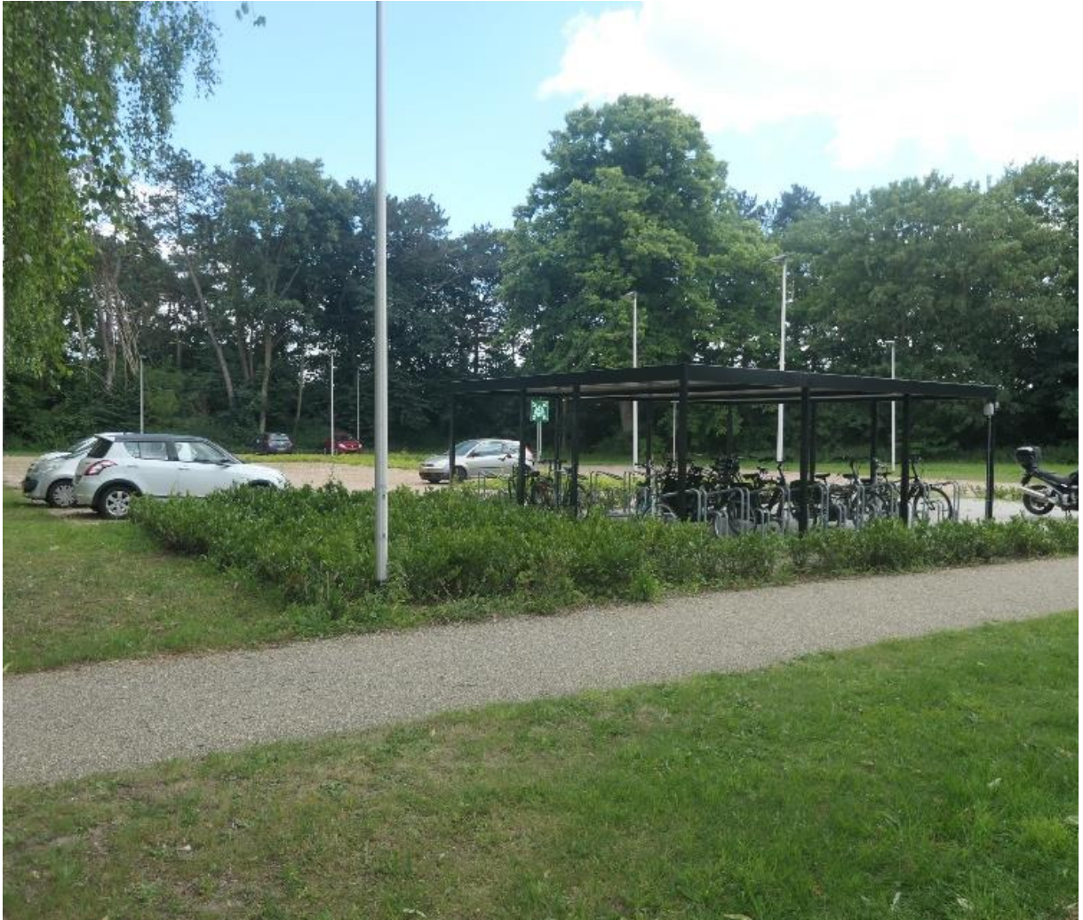
Figuur 3.1: Transparante fietsenstalling
